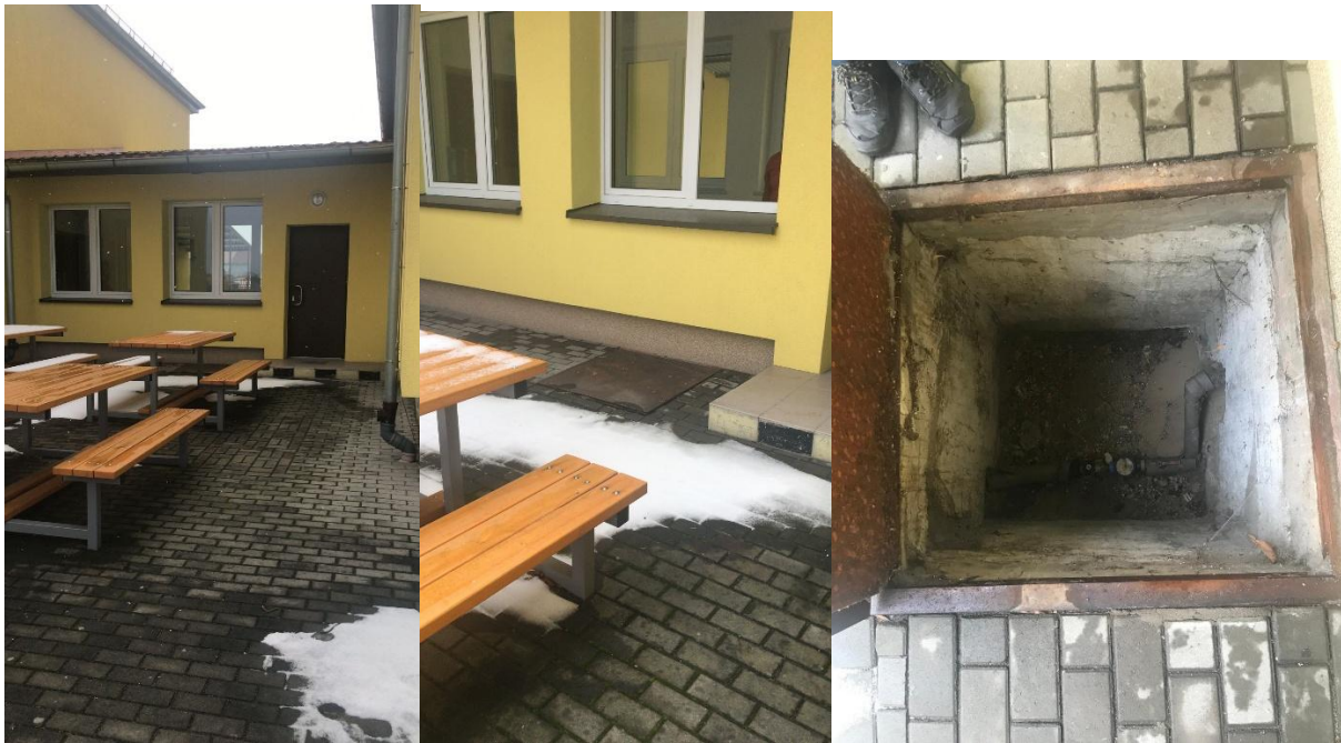
Istniejący łącznik i przyłącze wody
