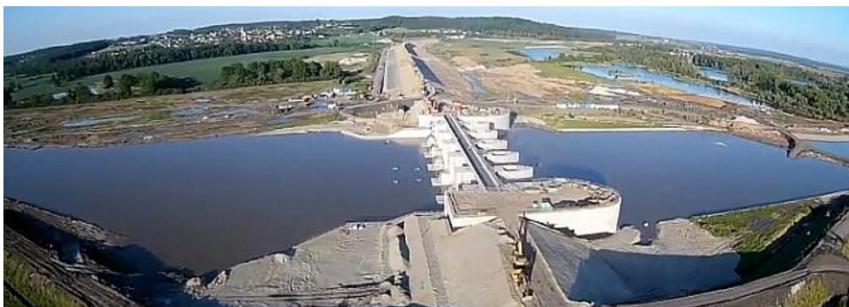
Fot. Główna zapora zbiornika Racibórz Dolny wraz z widocznymi obwałowaniami.
